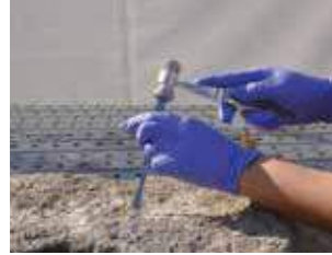
(a) 가설구조물 및 외부 가림막 설치 (b, c) 몰탈 제거
